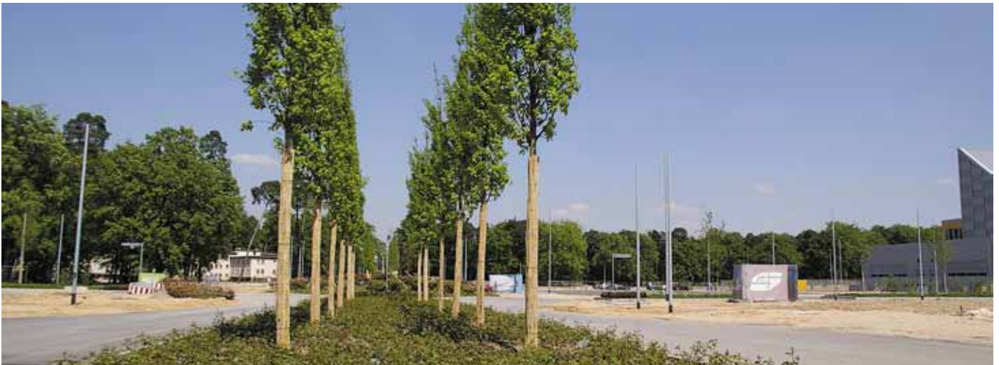
Straßenbau und Platzgestaltung – Gateway Gardens am Frankfurter Flughafen.
