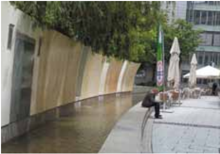
Großprojekt – Die Welle in Frankfurt am Main. | Fotos: Alle Referenzbeispiele: Fichter
