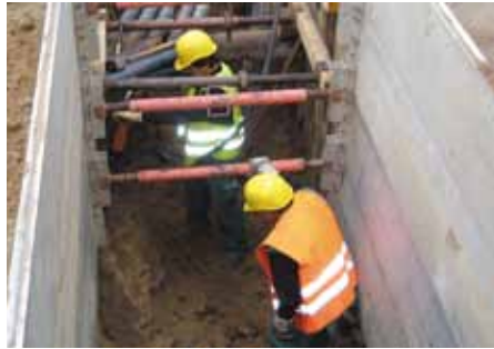
Kanal- und Rohrleitungsbau – Kongress- und Wissenschaftszentrum Darmstadt.
